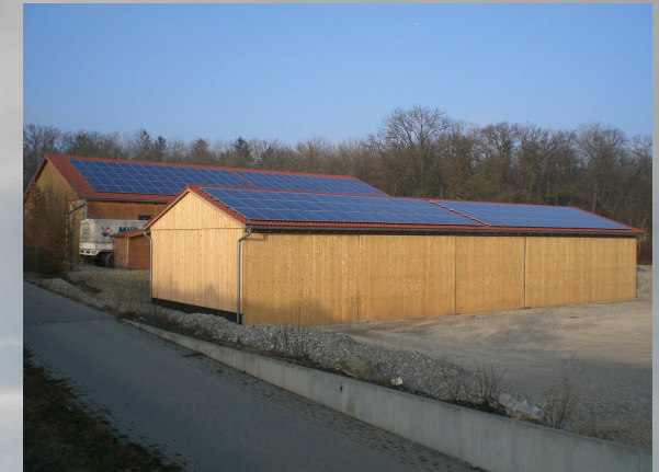
Bürgersolarkraftwerk Aschheim III an der Gerätehalle II des gemeindlichen Bauhofes (im Hintergrund BSK Aschheim I)
