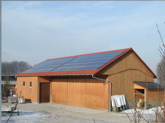
Bürgersolarkraftwerk Aschheim I an der Vereinslagerhalle, verlängerte Industriestraße
