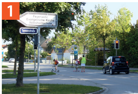
Fußgängerampel Ismaninger Straße/Weidachstraße/Tannenstraße
